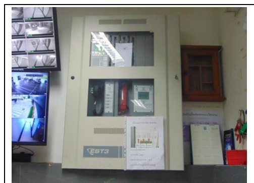
แผงควบคุมระบบแจ้งเหตุเพลิงไหม้
